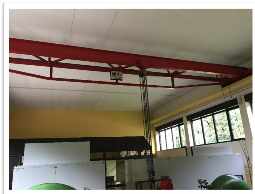
Bild 2: Ansicht der bestehenden Portalkranbahn
